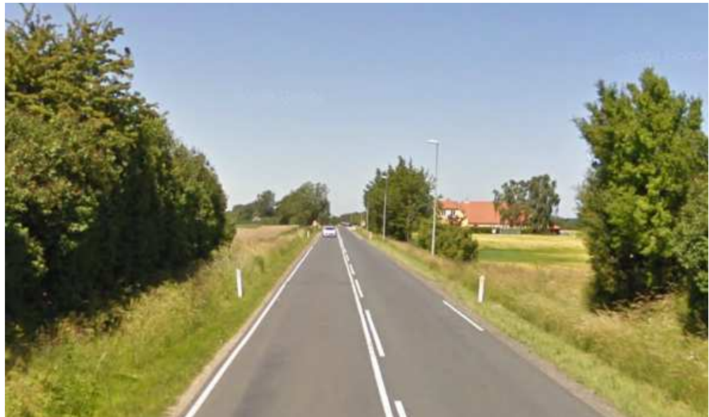
Figur 21 Bøgebjergvej umiddelbart nord for Brobyværk.
