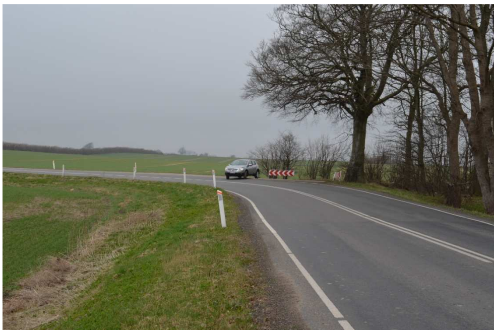
Figur 27 Skarp kurve på Karlsbjergvej øst for Brobyværk
