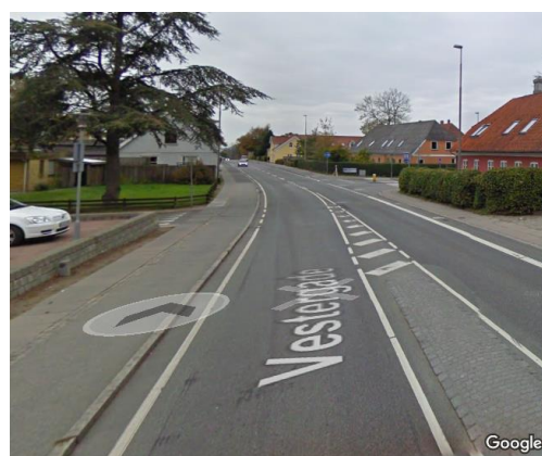
Vestergade vest for Søvej med cykelbaner. ©2018Google
