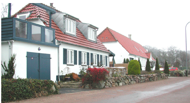
Stendige (uden beplantning ovenpå) foran Dyreborgvej 63.
