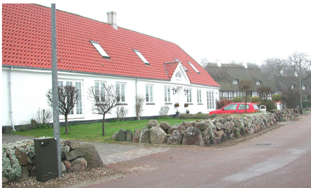
Stendige (uden beplantning ovenpå) foran Dyreborgvej 65.
