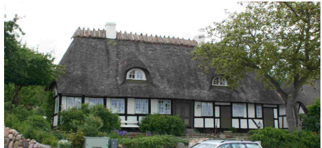
Dyreborgvej 67B. Bygningen fremtræder velholdt med fyldings hoveddør og øvrige facadedøre som staldøre af revler – facaden fortæller om husets historie. Stråtag med mønning fastholdt af kragetræer. Skorstenspiber hvidkalkede.
