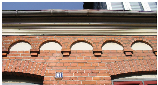
Trukket gesims, Priorensgade 31
