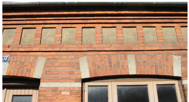
Aftrappet gesims, Priorensgade 37
