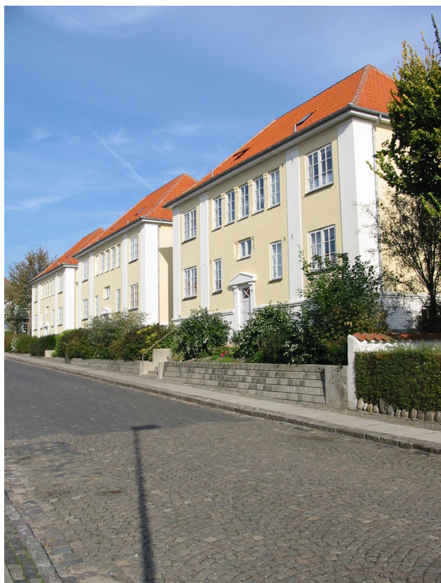
På Øster Møllevej 12, 14 og 16 rejser tre ens bygninger sig på sydsiden af gaden som en magtfuld frontbebyggelse
