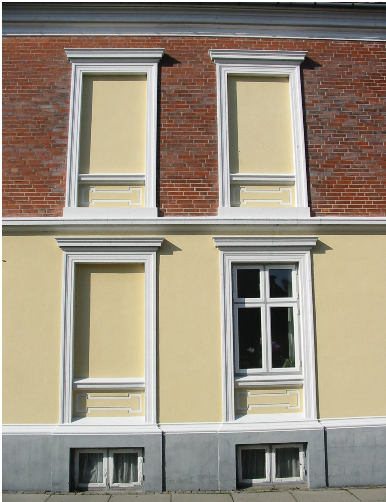
Hjørnet af Østerbrogade 61 og Holsten Carisiusgade. Symmetrien skal være i orden, også selvom der ikke er behov for vinduer – det skaber ro og balance
