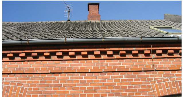
Sparrenkop gesims, Priorensgade 39
